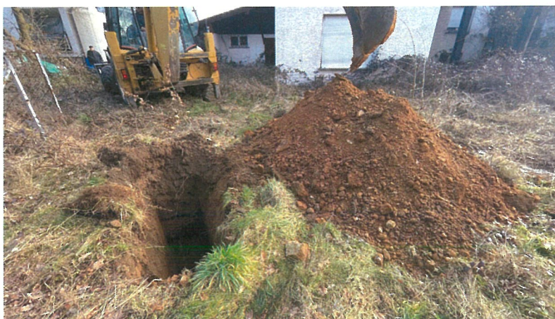
Slika 6: Sondažni izkop S-2.
